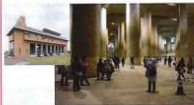
首都圏外郭放水路の一般見学
