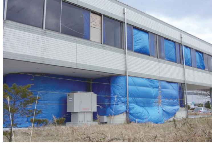
▲震災の3日後に出荷業務を再開した二本松物流センター
